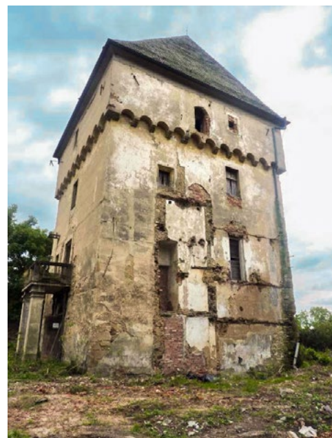
Na další fotografii z roku 2014 je patrná degradace objektu, kde schodišťový přístavek již podlehl destrukci a zůstal pouze „otřísť“ v severozápadní fasádě objektu. Foto Josef Bambas. © Národní památkový ústav, územní odborné pracoviště v Praze
