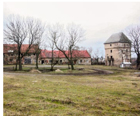
Celkový pohled na jižní hospodářskou budovu dvora od severu před rekonstrukcí. Vpravo věž tvrze. © Portál památkové péče hlavního města Prahy
