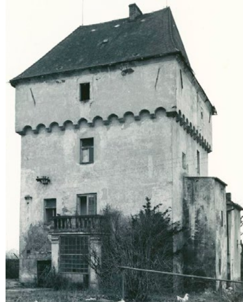
Pohled na věž tvrze od severu někdy po roce 1964, kdy již fakticky chátrala. Na severní fasádě (vpravo) ještě vidíme dochovanou hmotu schodišťového přístavku. Foto neznámý autor. © Národní památkový ústav, územní odborné pracoviště v Praze
