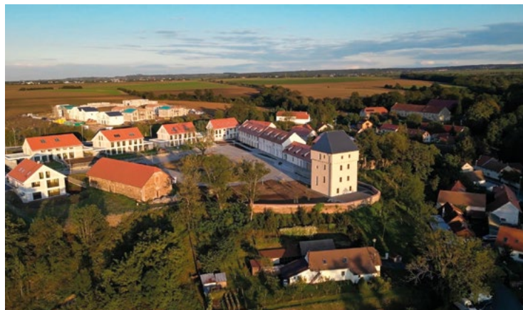
Letecký pohled od severozápadu na dokončenou první a druhou etapu výstavby rezidenčního bydlení v místě původního královického dvora. V pozadí postupně roste třetí etapa výstavby. © Doležel Architekti, s. r. o.
