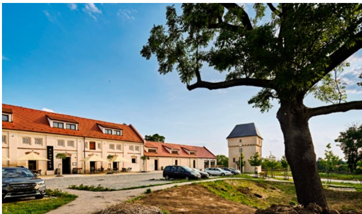
Celkový pohled od východu na jižní hospodářskou budovu dvora (vlevo) s tvrzí po rekonstrukci. Foto Andrea Thiel Lhotáková, 2024
